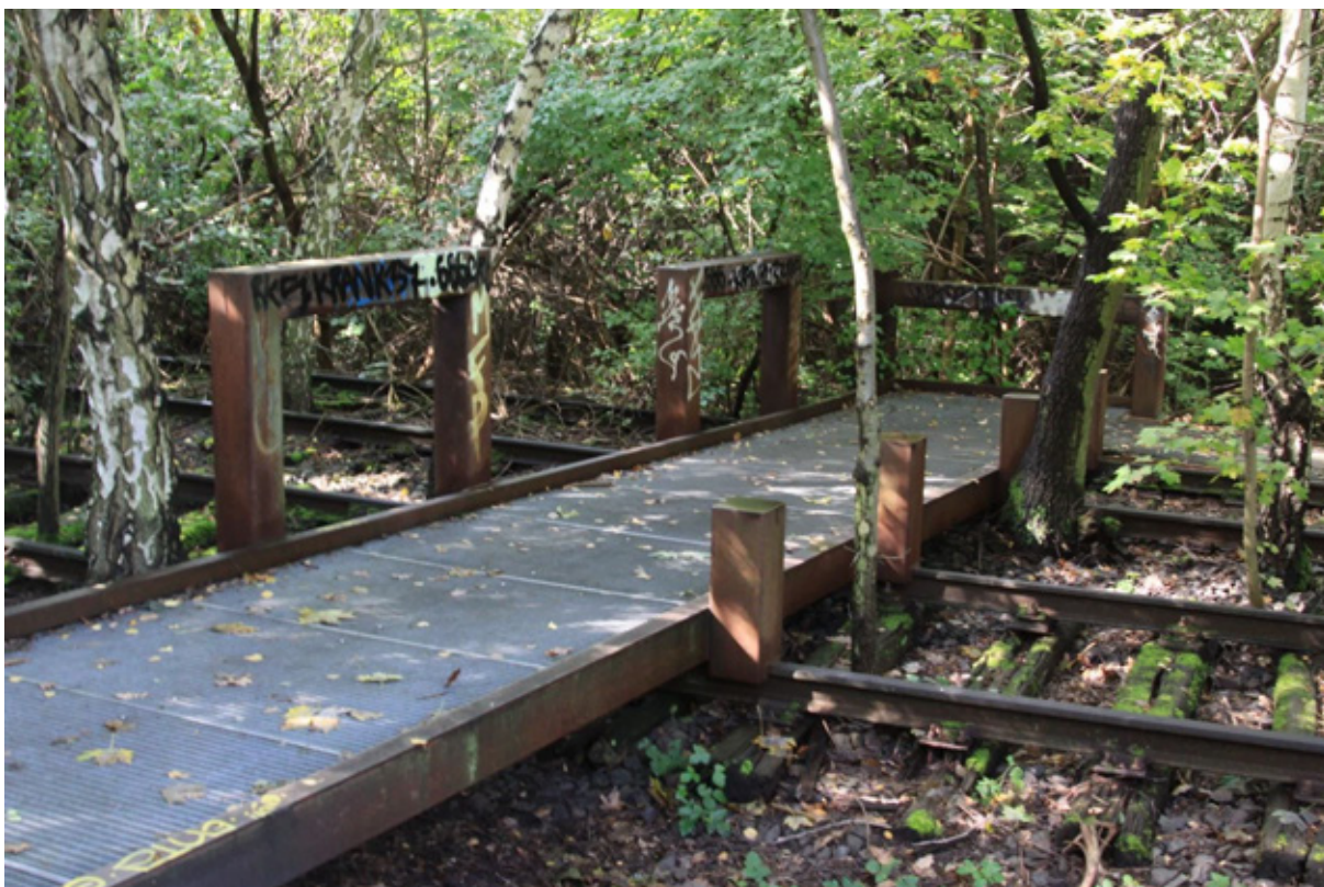
Fig. 5.3.5 - Imagine de detaliu din cadrul Natur-Park Súdgelände care surprinde infrastructura de vizitare a zonelor naturale; se remarcă faptul că circulația pietonală sprijină pe șinele de tren care sunt poziționate peste traverse de lemn
