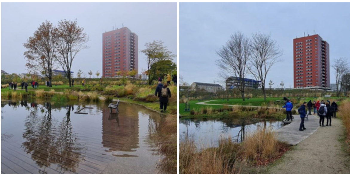
Fig. 5.2.3 - Exemplu referitor la conformația bazinelor de retenție din cadrul SPARK: (stânga, septembrie 2022) imagine cu bazinul de retenție într-o perioadă de maxim pentru aportul de apă provenită din precipitații; (dreapta, decembrie 2022) imagine cu bazinul de retenție într-o perioadă fără precipitații, în cadrul căreia sunt vizibile elementele de mobilier urban și pontonul lacului
