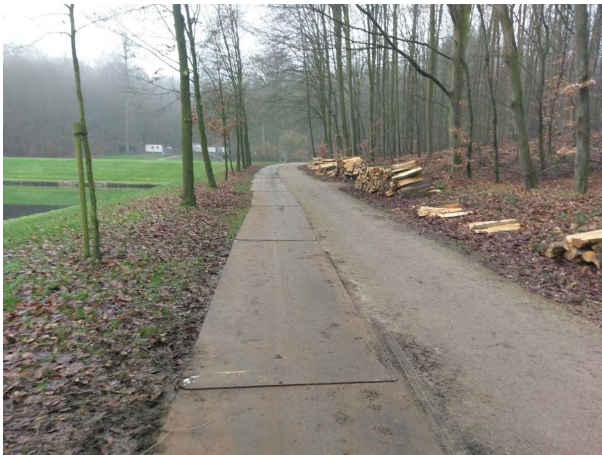
Fig. A1.6 - Exemplificare a modului în care poate fi protejat solul pe parcursul realizării intervențiilor în zonele pe care se deplasează echipamentele grele: soluție tehnică în care sunt utilizate foi groase de tablă
