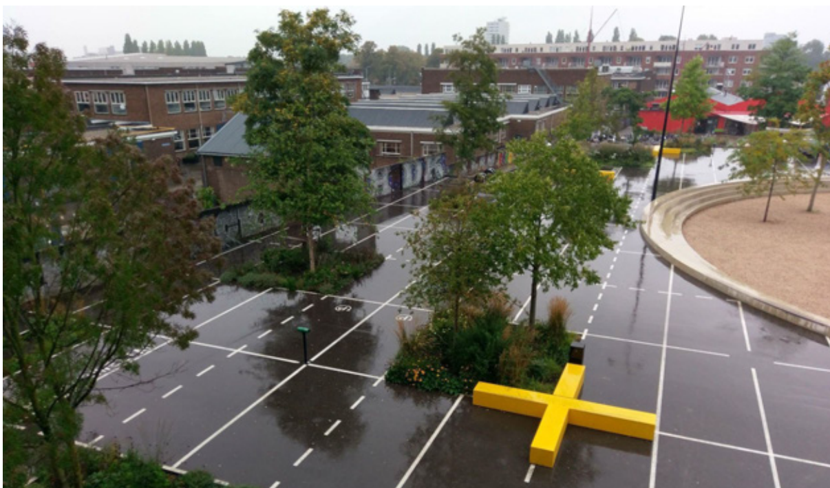
Fig. 1.6.5 - Exemplu de introducere a unor elemente vegetale în structuri de tip sponge city în cadrul unei parări din orașul Amersfoort din Olanda
